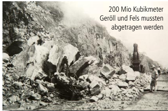
Mit einem raffinierten System von Eisenbahnzügen auf mehreren Terrassen wurde das Material abtransportiert
