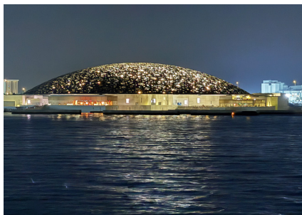
Auslaufen aus Abu Dhabi: Blick auf den nächtlichen Louvre...
